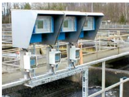
Flödesmätare för att mäta slam
